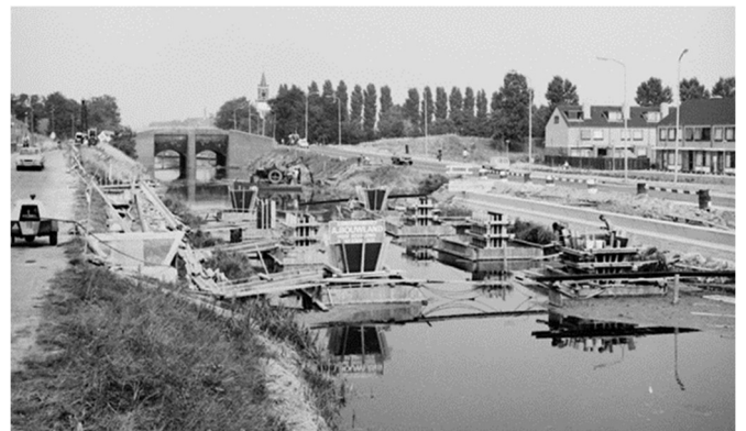
BOUW BRUG PAXLAAN - FOTO NHA
