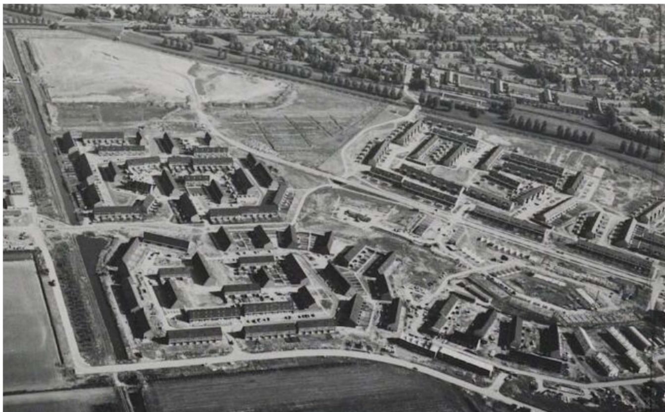
Pax in aanbouw: Schweitzerstraat links midden, Kellogg- en Bernadottestraat onder en Wilsonstraat rechts midden. In het midden de Dunantstraat in aanbouw
