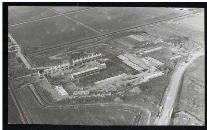
Luchtfoto Schweizerstraat in aanbouw – foto NHA
