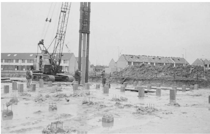
Heiwerkzaamheden flats – foto NHA
